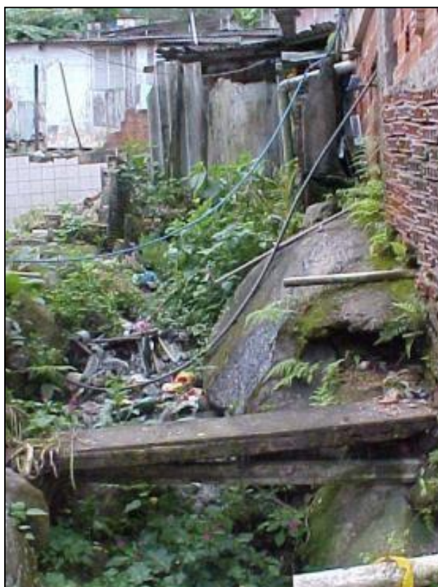
Figura 5: Drenagem natural transformada em ponto de lançamento de águas servidas, lixo e esgoto – Vila Baiana.
