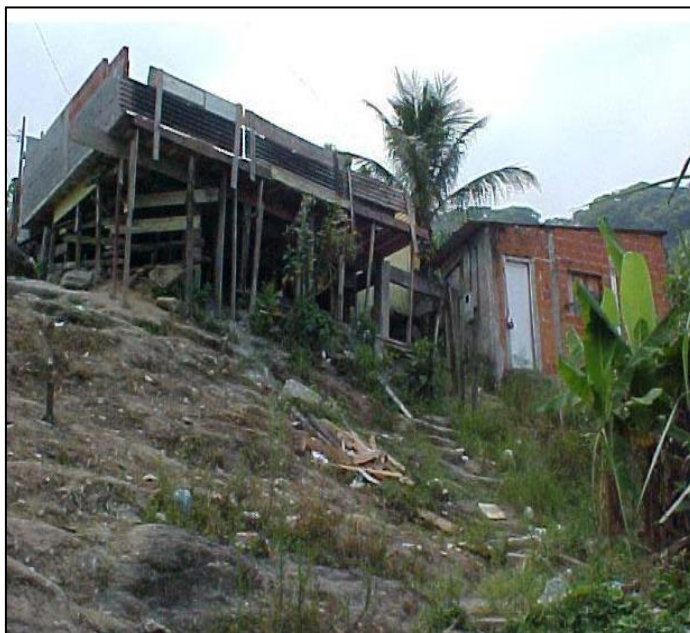
Figura 4: Moradia com base do tipo palafita sobre terreno de rocha alterada dura – Jardim Bela Vista.
