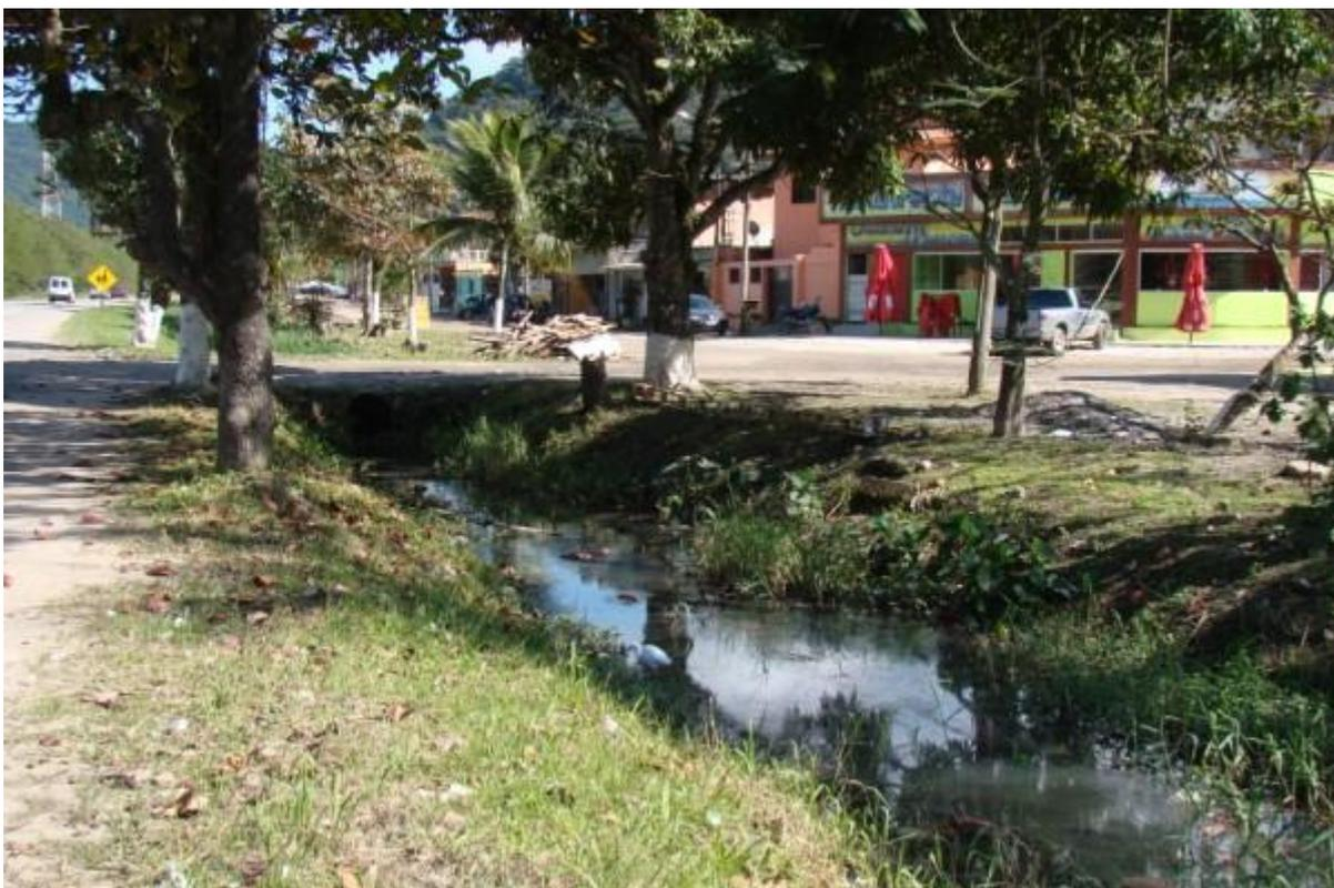
Fotografia 03: Valetas de drenagem, indicando lançamento de esgoto doméstico e grande quantidade de lixo
